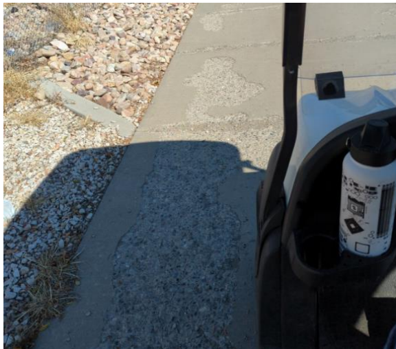
SPALLING
