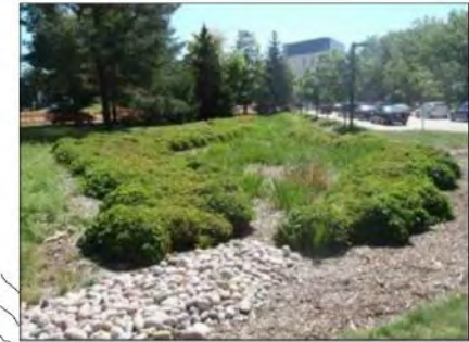
LID BIORETENTION SWALE
