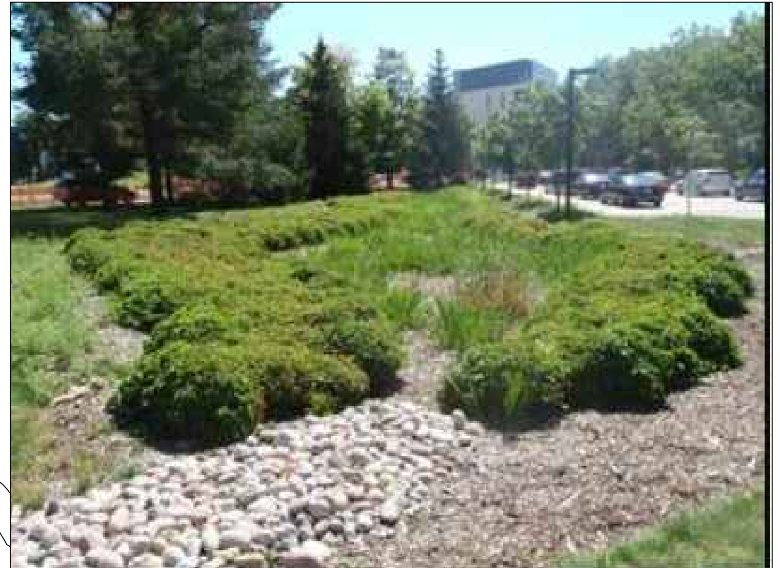
LID BIORETENTION SWALE
