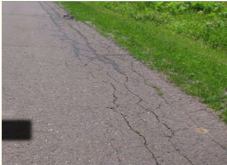
Edge Cracking
